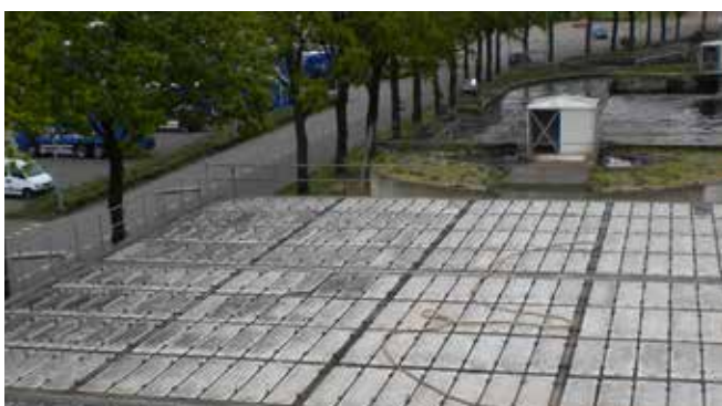
Bovenaanzicht van de anaërobe zuiveringsreactor
